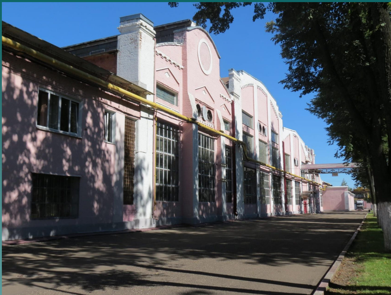
Ярославский паровозоремонтный завод.
